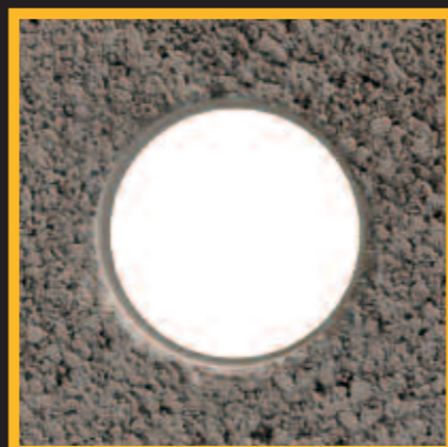
Otvor vyvrtaný diamantovým korunovým vrtákem
